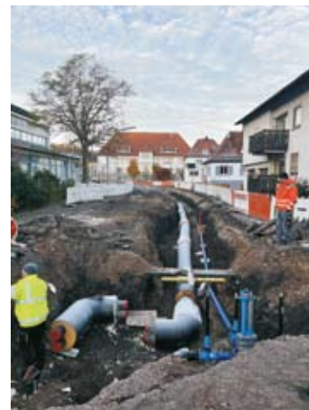
Übergabestation im Vereinshaus Bau Nahwärmenetz in der Schulstraße
