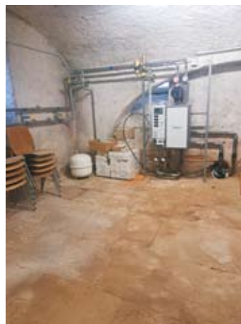
Übergabestation im Vereinshaus Bau Nahwärmenetz in der Schulstraße
